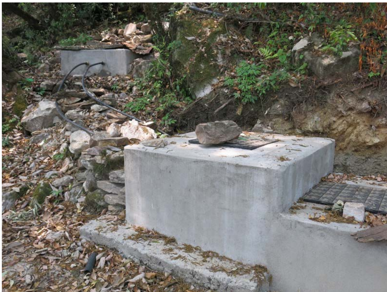
Uiya : captage et réservoir.
