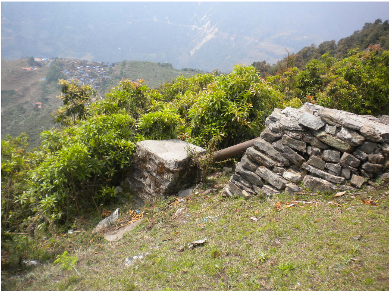
Partie supérieure « conduite forcée »
